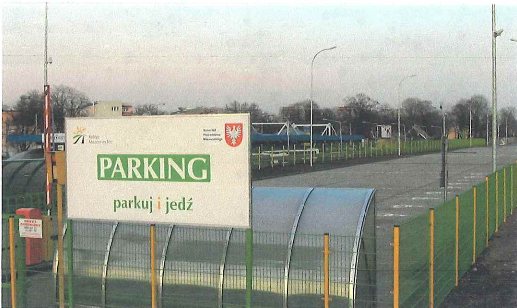
Rys. 7.3 Parking P+R Radom Główny.
